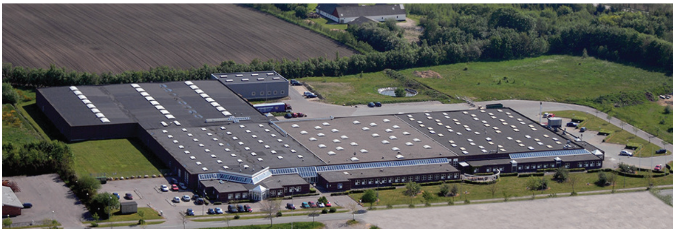
Die OPTICON-Lautsprecher werden mit eigenen und von den weltweit besten Lieferanten zugekauften Bauteilen in der dänischen DALI-Fabrik montiert.
